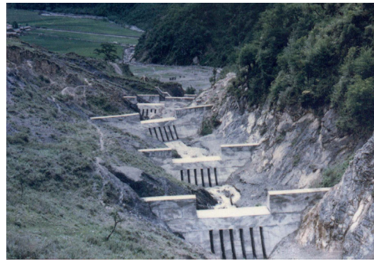
圖片 6 九寨溝泥石流防治工程——攔沙壩群
