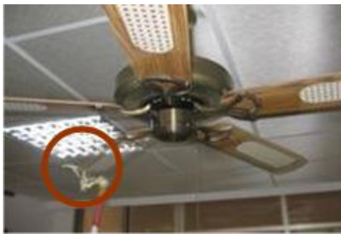
图 14: 吊扇反转吸引纸条往上飘
